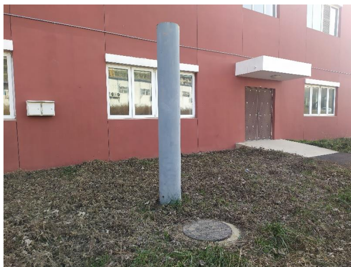
图4-1 锅炉房降温池
